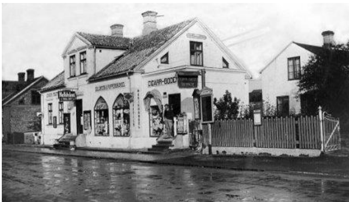
Ovanför dörren till vänster hänger skylten till Hellströms bok- och pappershandel, som låg på Köpmannagatan i Åhus. (Bilden hämtad från http://ahus.annasgille.com )
